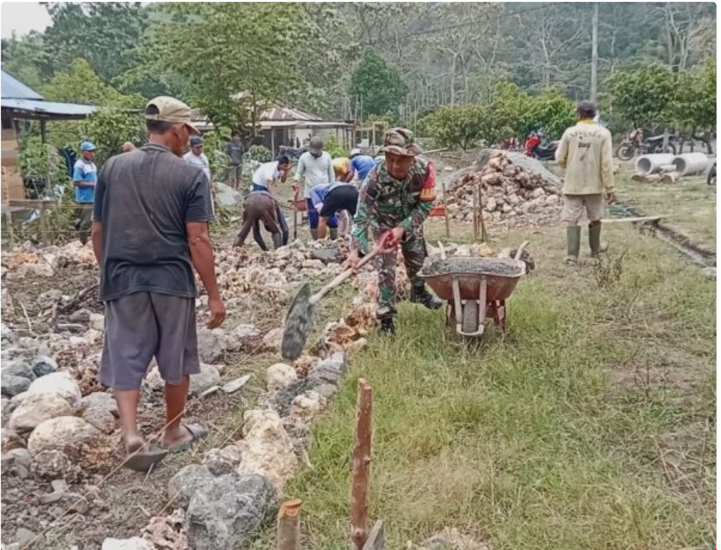
Gotong royong bangun pondasi rumah warga
